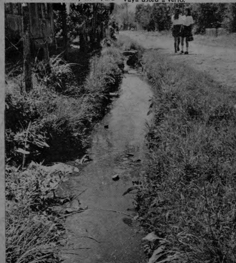
Por estas zanjas, con aguas estancadas, creadero de todo tipo de microbios, usted sabrá que se encuentra en San Isidro de El Guarco.
